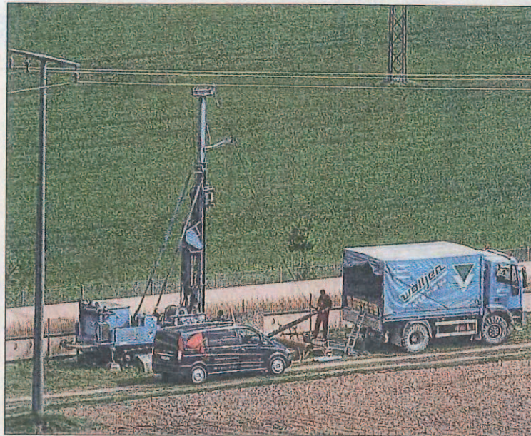
Im Blautal sind Bohrungen angelaufen. Für den Bau des Kraftwerks wird während eines Pumpversuchs der Grundwasserspiegel gemessen. Foto: Joachim Striebel
